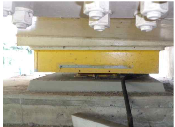
교량 받침 가동량 측정
