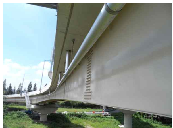
배수관 상태 양호
