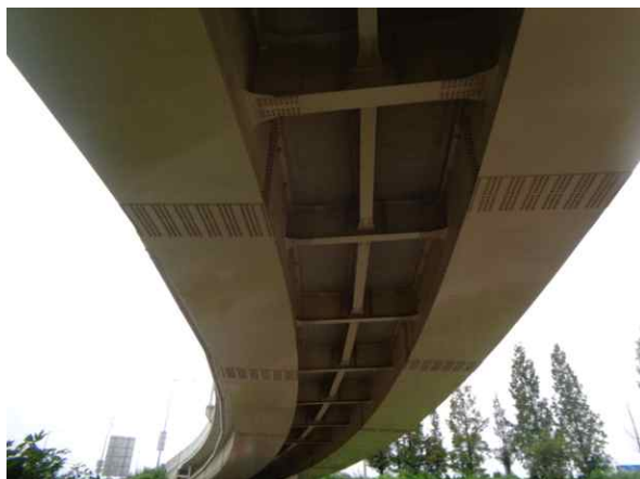
거더외부, 바닥판하면 전경
